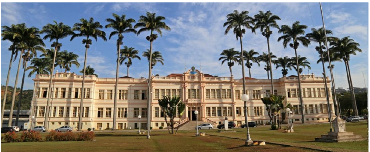
Figura 5 – Edifício Arthur Bernardes da UFV Campus Viçosa. Fonte: UFV, 2022.
