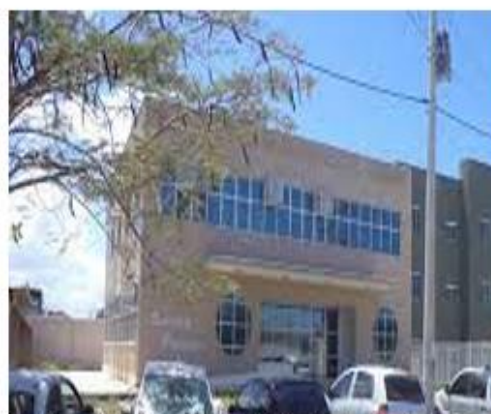
Prédios do Serviço de Psicologia Aplicada e Moradia Estudantil
