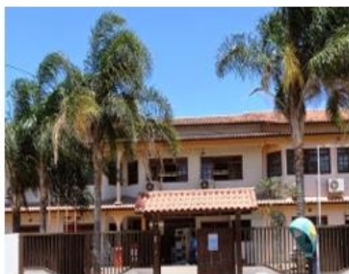
Prédio onde funciona o Instituto de Humanidades e Saúde da UFF
