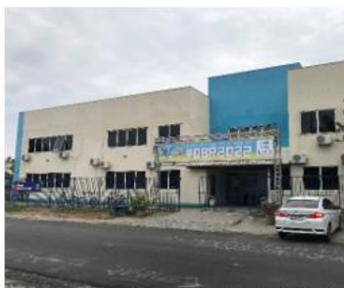
Prédio onde funciona o Instituto de Ciência e Tecnologia
