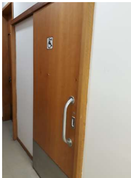
Figura 22: Porta do sanitário para PcD - Sede Ecoville
