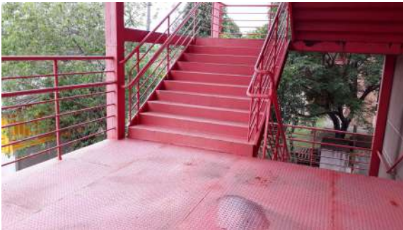
Figura 30: Escada de Emergência Sede Ecoville
