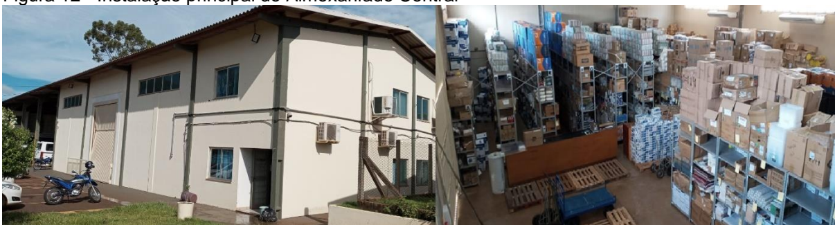
Figura 12 - Instalação principal do Almoarifado Central
